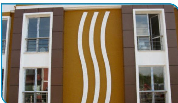
Kompozit Panel Kaplama    Composite Panel Wall Cladding
